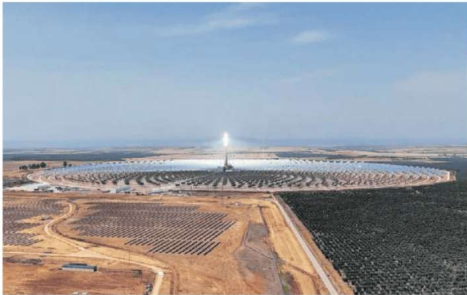
Central termosolar Gemasolar, en Fuentes de Andalucía (Sevilla). HUW EVANS (CORDON)
